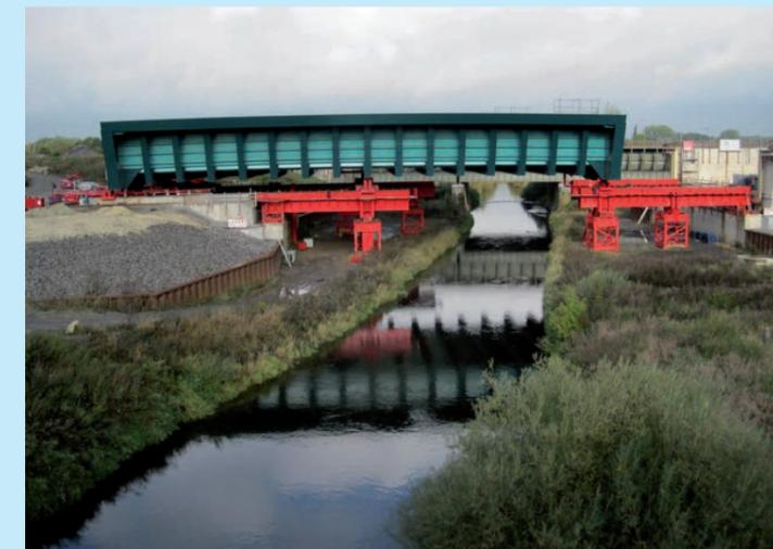
↑ Verschiebung eines Brückentrogs am DEK © WSV
